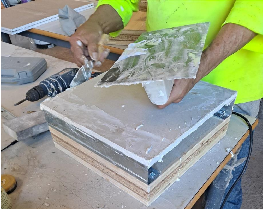
Imagen 6. Aplicación de un mortero especial, no permeable, a otro prototipo trasdosado de sistema aislante IDSIATE, en que puede verse el tablero IDSIATE, los perfiles metálicos y la placa de yeso laminado.
