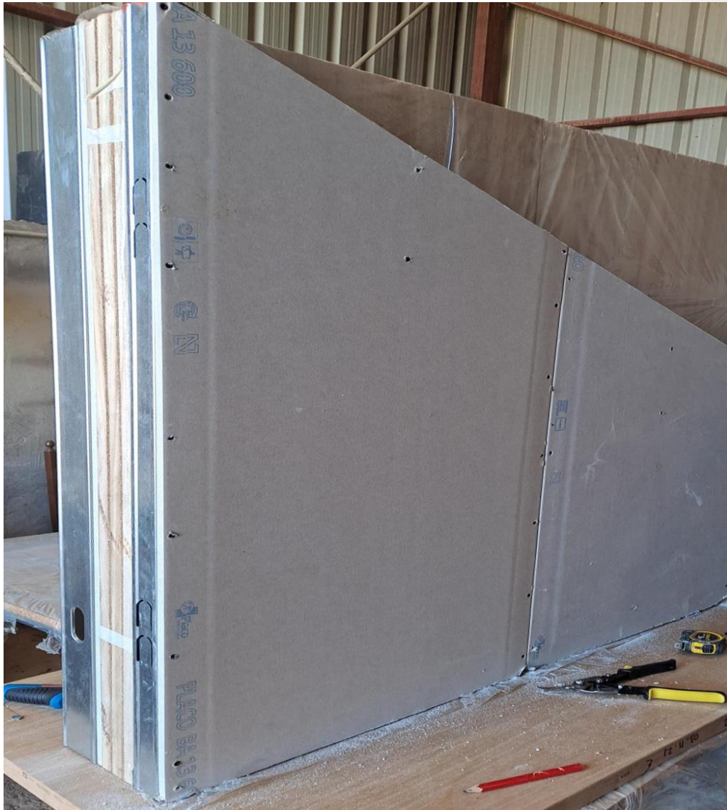
Imagen 4. Desarrollo de un prototipo trasdosado de sistema aislante IDSiate, en que puede verse el tablero IDSiate con la barrera de vapor, los perfiles metálicos y la placa de yeso laminado.
