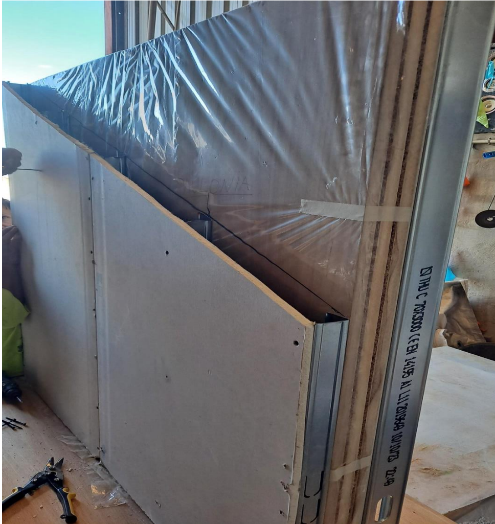
Imagen 5. Desarrollo de otro prototipo trasdosado de sistema aislante IDSiate, en que puede verse el tablero IDSiate con la barrera de vapor, los perfiles metálicos y la placa de yeso laminado.
